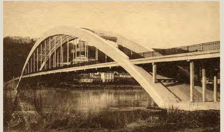
Le second pont en béton armé, 1934-1940
