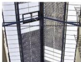
Les capteurs photovoltaïques sont intégrés à la verrière de la galerie de distribution d'une résidence HLM.
