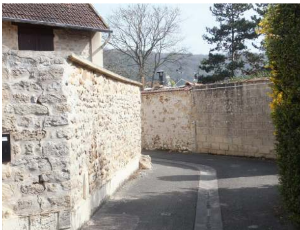
Qualité des murs à Moisson
